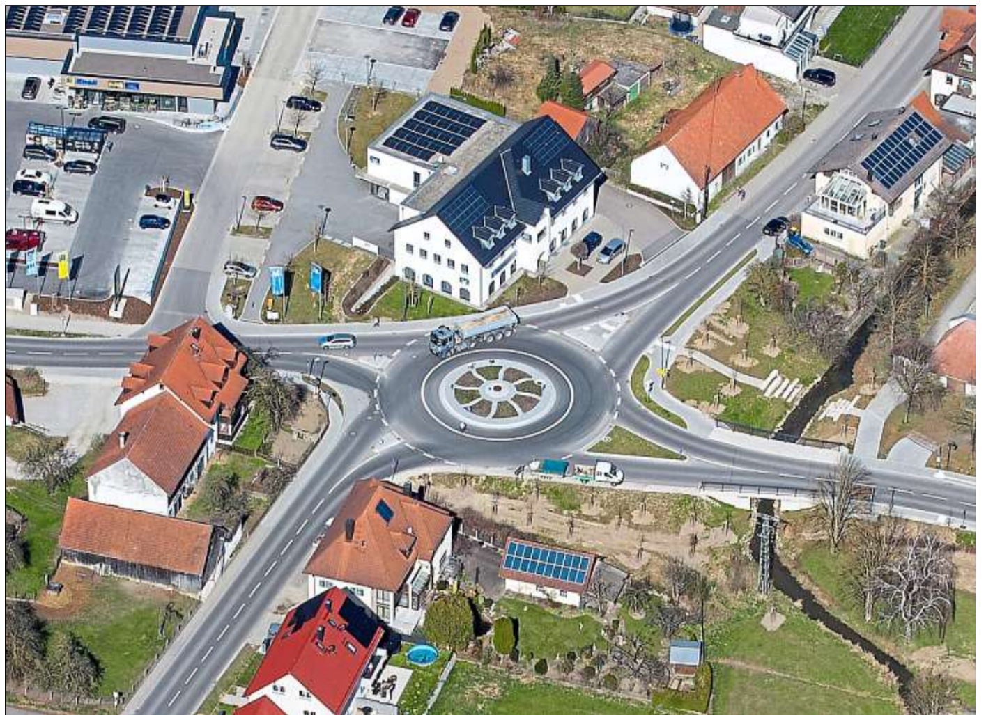
Der Kreisverkehr prägt seit mehr als einem Jahr die Gerolsbacher Ortsmitte. Doch erst jetzt sind alle Verfahren, die im Zusammenhang mit dem Bauprojekt liefen, abgeschlossen. Foto: Rainer Halbfürter
